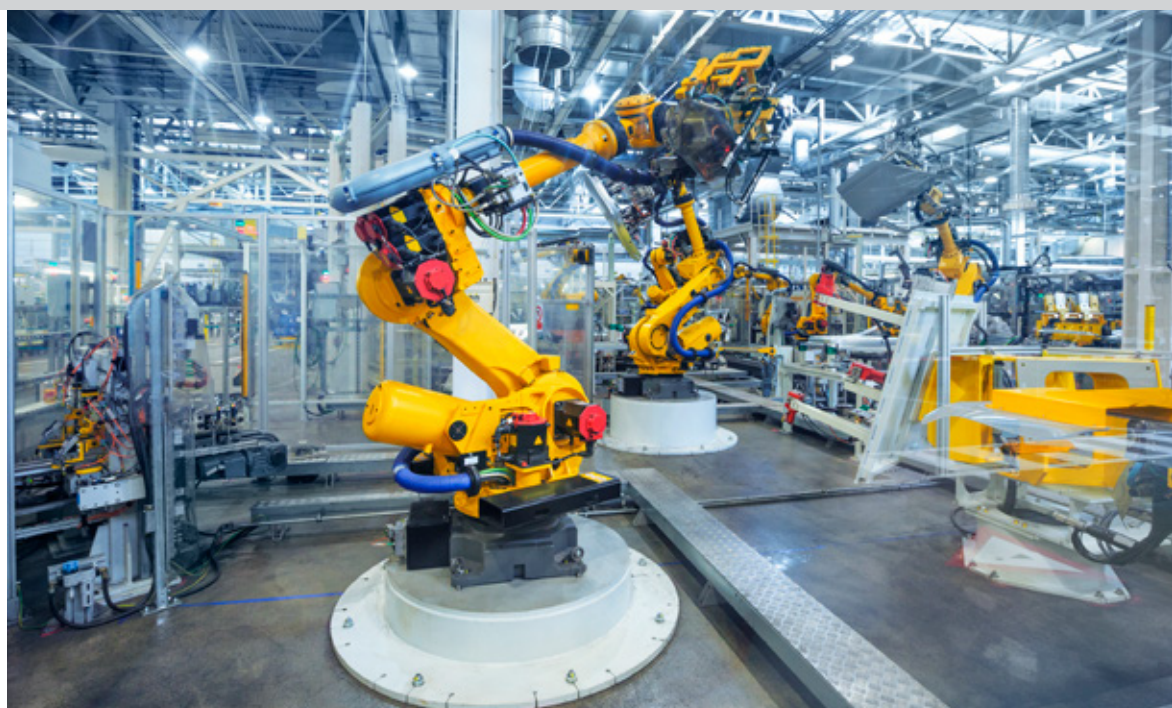
Rechtzeitige Wartung erhöht die Anlagenverfügbarkeit: Dank DCTR können elektrische Fehler bereits im Entstehen erkannt und Gegenmaßnahmen frühzeitig und kostensparend ergriffen werden
